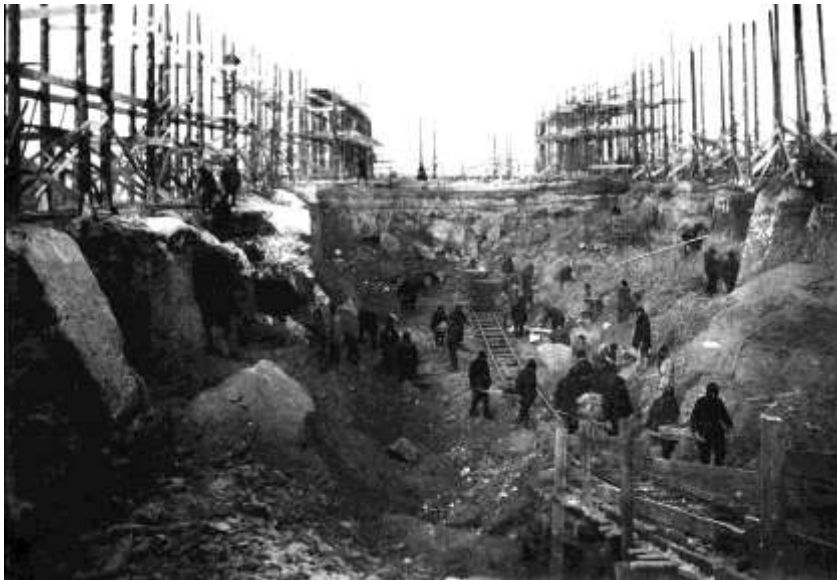
Начало строительства котлована под реактор на объекте А
