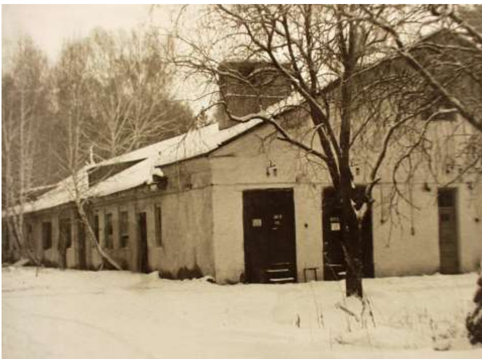
Здание №9 завода "В", где была получена первая партия плутония. Сейчас, ввиду смертельно опасного загрязнения Плутонием, здание захоронено в могильник.
