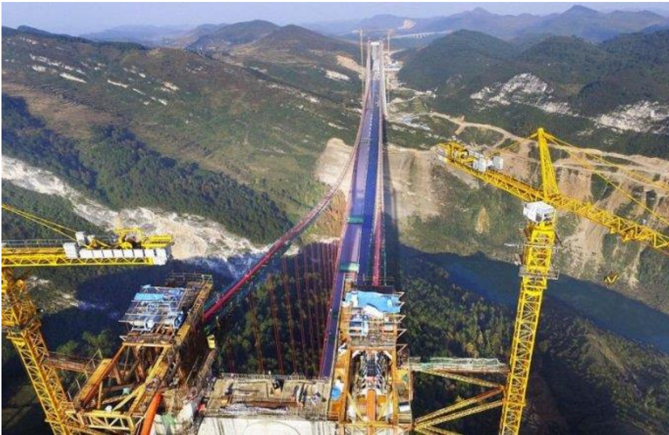
Строительство моста Веирапцзянг длилось 3 года.
